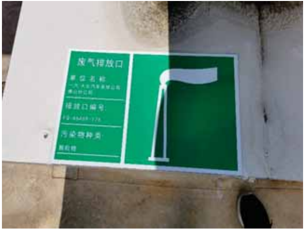
照片 4-16 焊接废气排放口标识牌 (FQ-46469-176)
