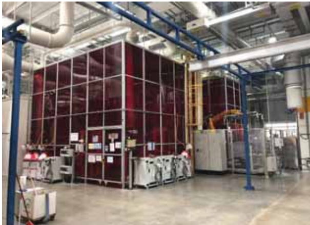
照片 4-1 电池壳体总成生产线固定焊房
